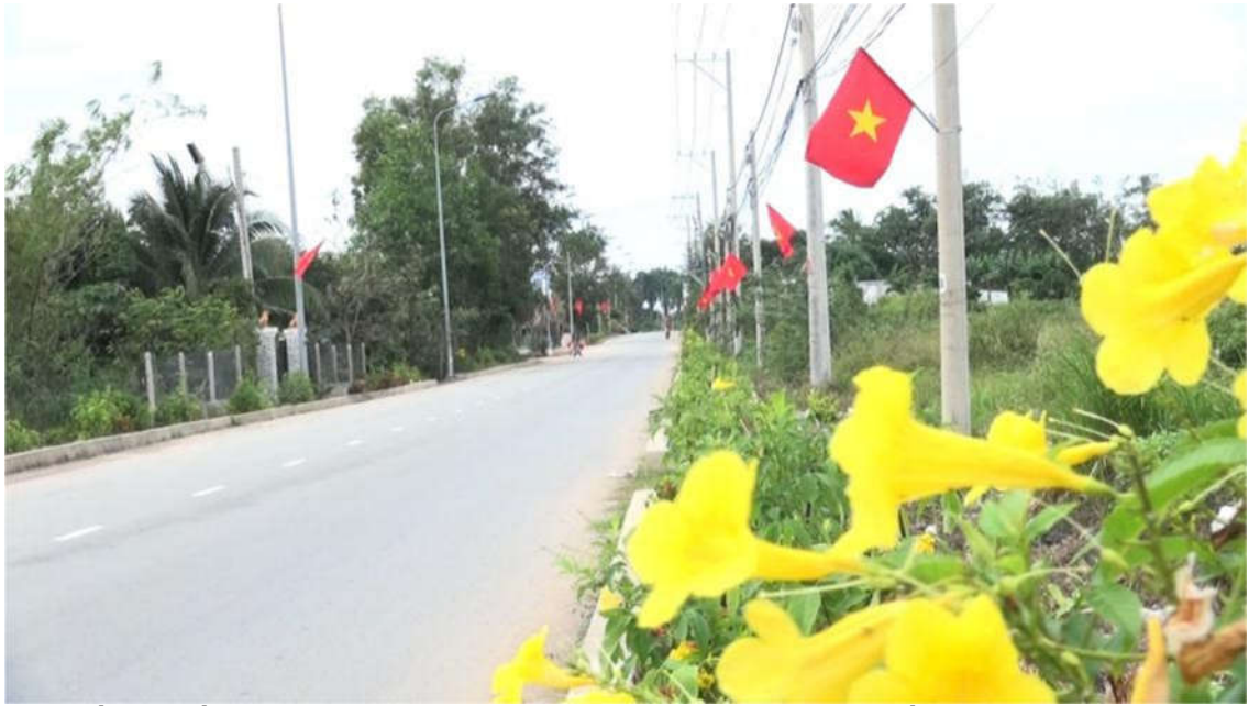
Nhiều tuyến đường liên xã đã được bê tông hóa và trồng hoa ven đường.
